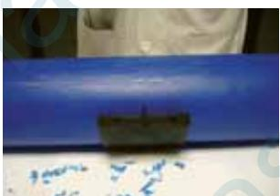
4 Установить Т-переходник на нижнюю часть посредством выравнивания канавок для вставки.
