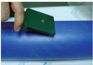
2 Удалить окислительный слой на трубе, очистить поверхность трубы, внутреннюю поверхность Т-переходника, поверхность сварки поворотной головки и выходные концы с помощью промышленного спирта.
