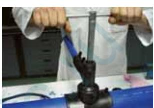
11 До конца закрепить верхнюю крышку Т-переходника поворотом по часовой стрелке. После этого установка завершена.
