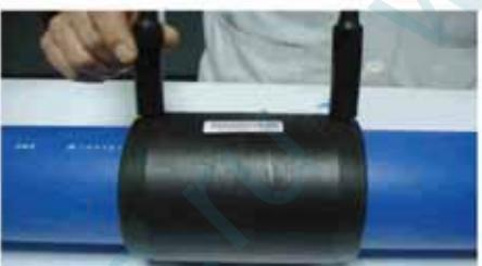
**5** Необходимо проверить, что он ровно сидит на трубах для электрофузионной сварки, закреплен и концы направлены вверх. Муфты сварочного аппарата поместить на свариваемые края фитинга и подготовить к сварке.
