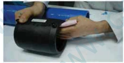
**3** Вынуть фитинги для сварки из упаковки, очистить поверхности, которые будут соединены электрофузионной сваркой с помощью промышленного спирта. Во время очистки свариваемых поверхностей трубы и фитингов следует избегать контакта с руками.
